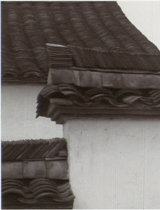
Utilización de la teja en un edificio tradicional de la zona. Use of the tiles in a traditional building of the area.
